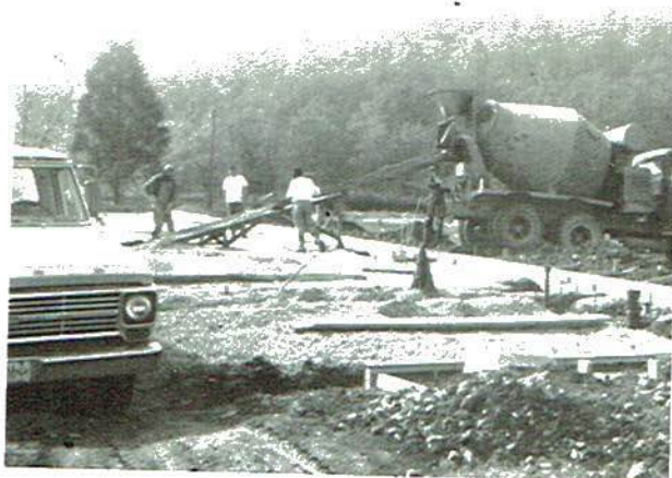
Pouring the cement.
